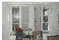
Fenster Raum 8.JPG
