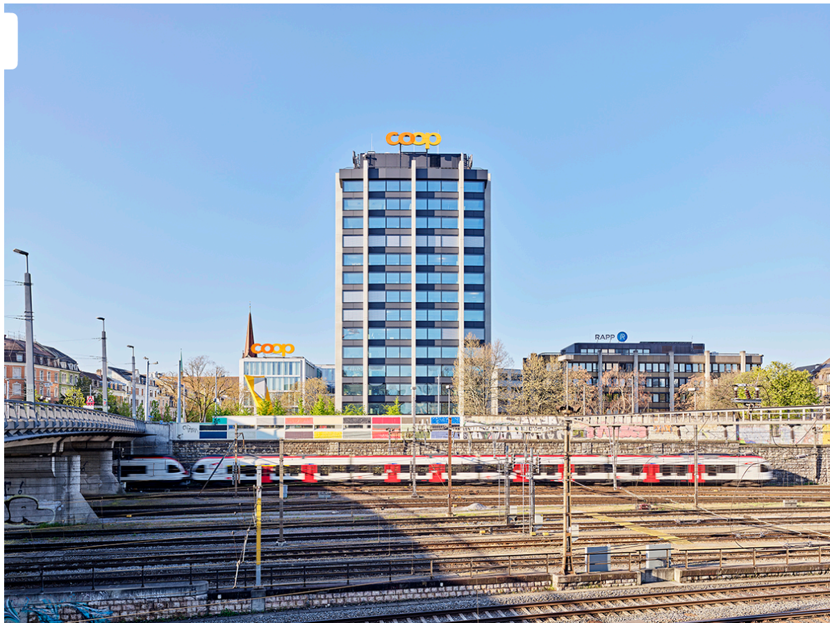
Ein Markstein fürs Gundeli: Das Coop Hochhaus © Burckhardt+Partner AG / Mark Niedermann.
