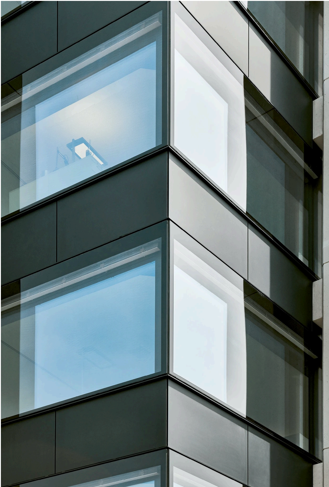
Mattglas-Photovoltaikelemente und Fenster wechseln sich ab.
