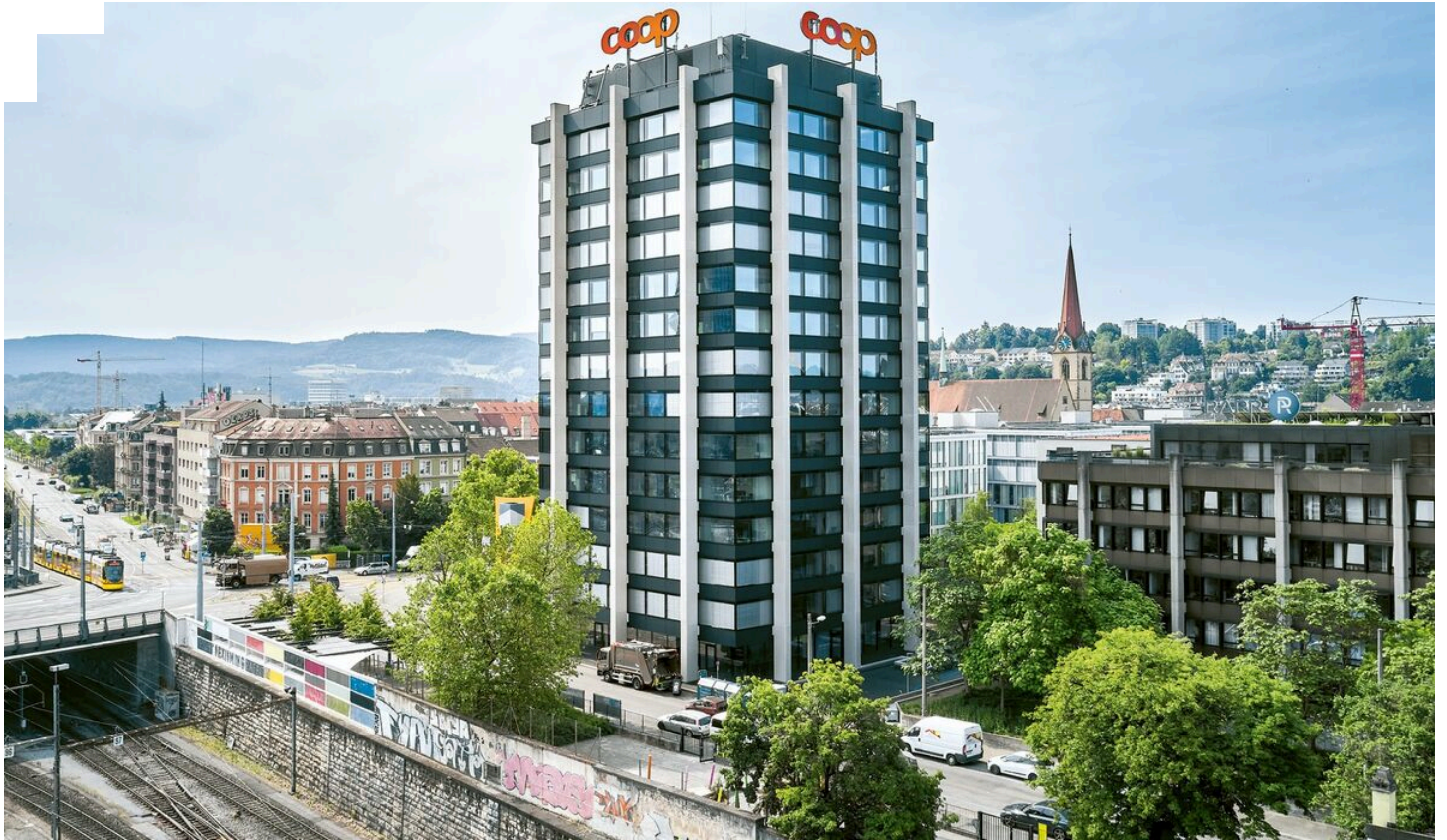
Das neue Gesicht des Coop-Hochhauses am Gleisfeld in Basel. Fotos: Zeljko Gataric
