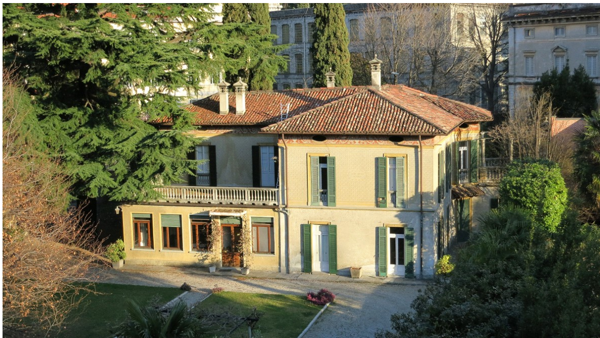
Abbildung 1: Villa Castelli vor der Sanierung
