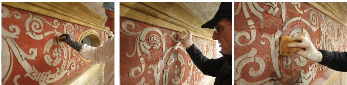
Abbildung 9: Konservatorische Restaurierung der Fassade
