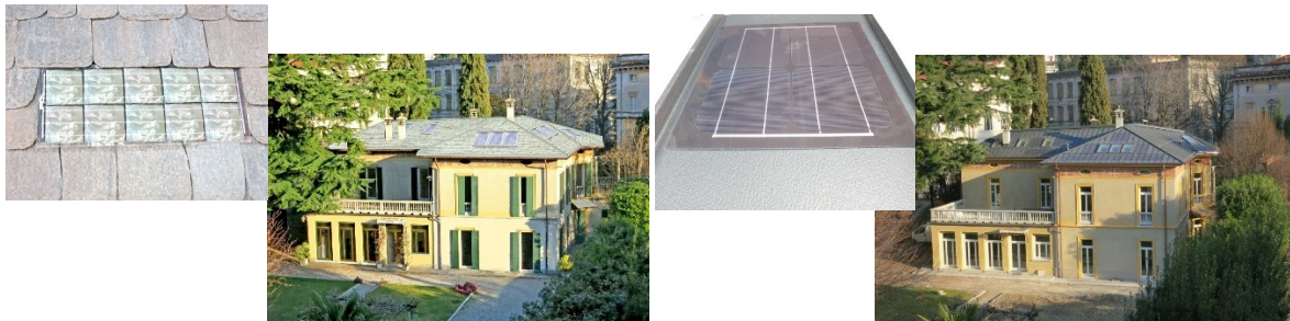
Abbildung 8: Zwei Prototypen für die dachintegrierte PV-Anlage
