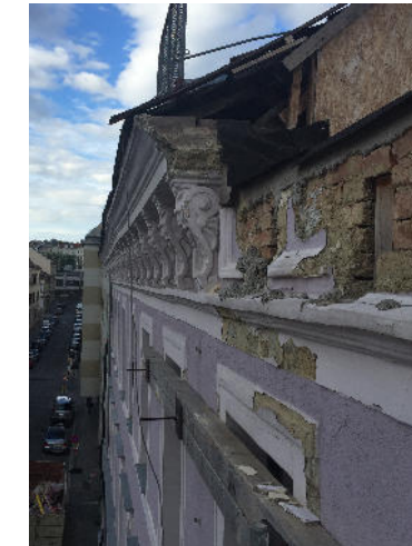
Zerstörtes Hauptgesimse
