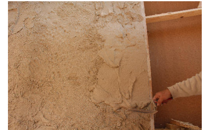
Aufbringen des Hochleistungsdämmputzes
