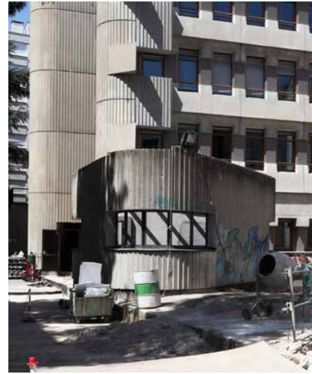
Le bunker : dépôt postal datant de 1974
