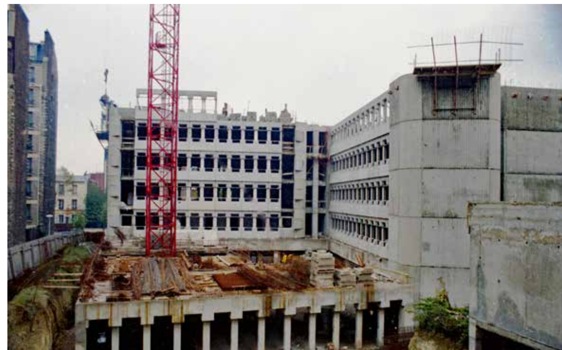
Le bâtiment en chantier en 1974, photographie de Denis Rolland, directeur de travaux de la SAE, devenue Eiffage.
