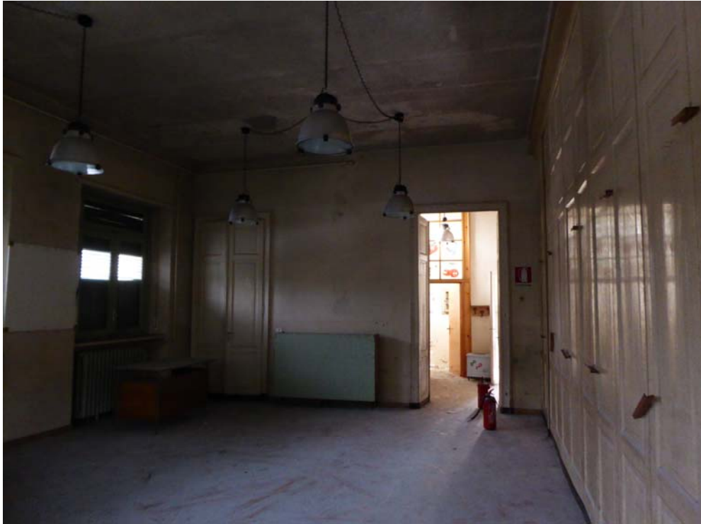
Figura 6, interno: aula a nord del piano terra
